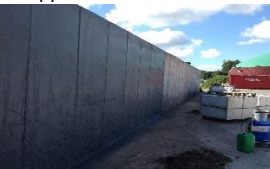
Neue Beschichtung mit Schutzlasur
